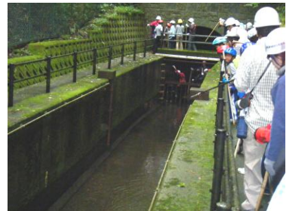
深良用水の取水口付近
